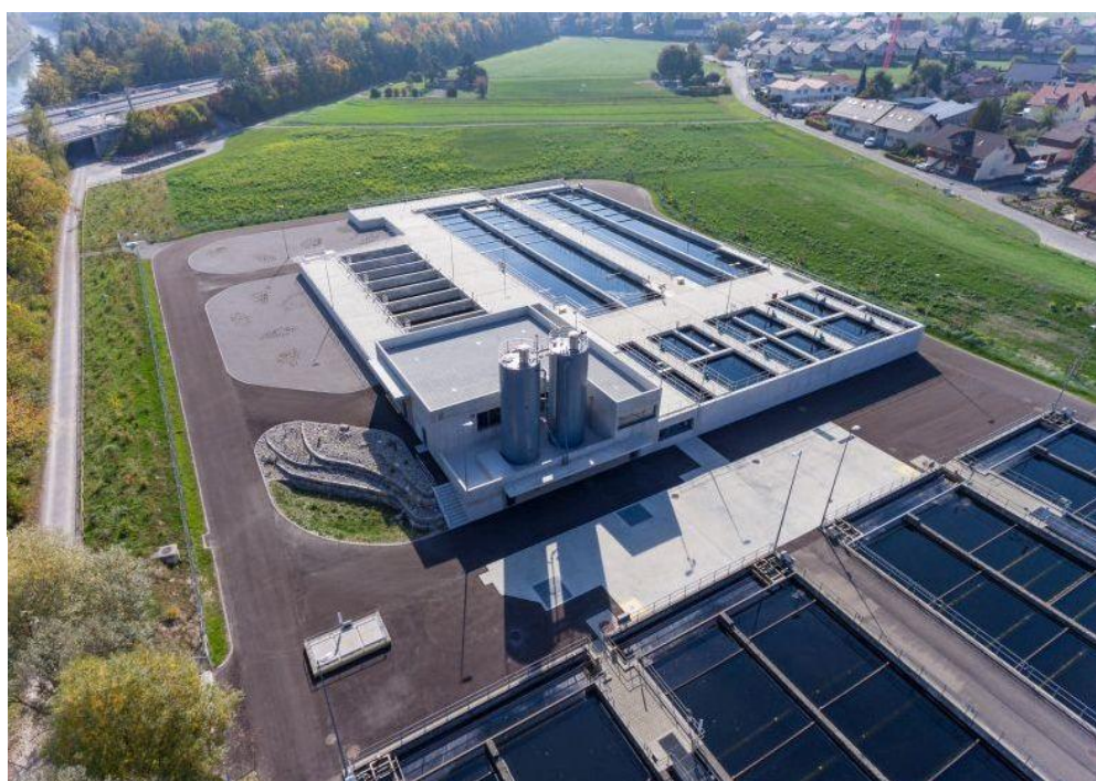
Die neue Reinigungsstufe zur Elimination von organischen Spurenstoffen mit Pulveraktivkohle auf der ARA Thunersee ist im Sommer 2018 in Betrieb gegangen (Foto ARA Thunersee)
