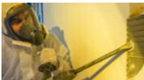
Abb. 19 Entfernen von asbesthaltigem Fliesenkleber (© Galli AG, Zuchwil).
