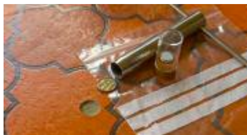
Abb. 20 Kunststoffbodenbelag mit Asbest (© Galli AG, Zuchwil).
