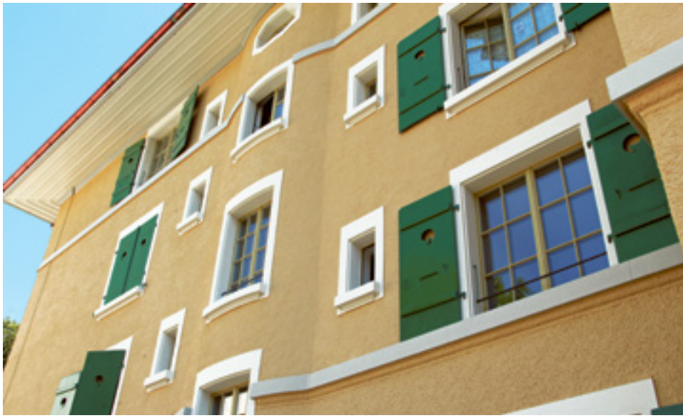
Fassadengestaltung mit Mineralfarbe, Wasenstrasse Biel.
