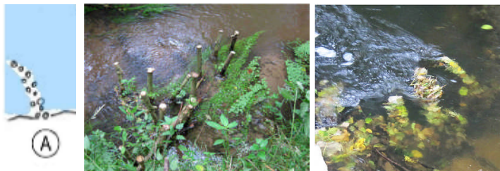
Abb. 1 Gestecktes Astwerk / Kleinpfähle (Fotos : L. Tent)
