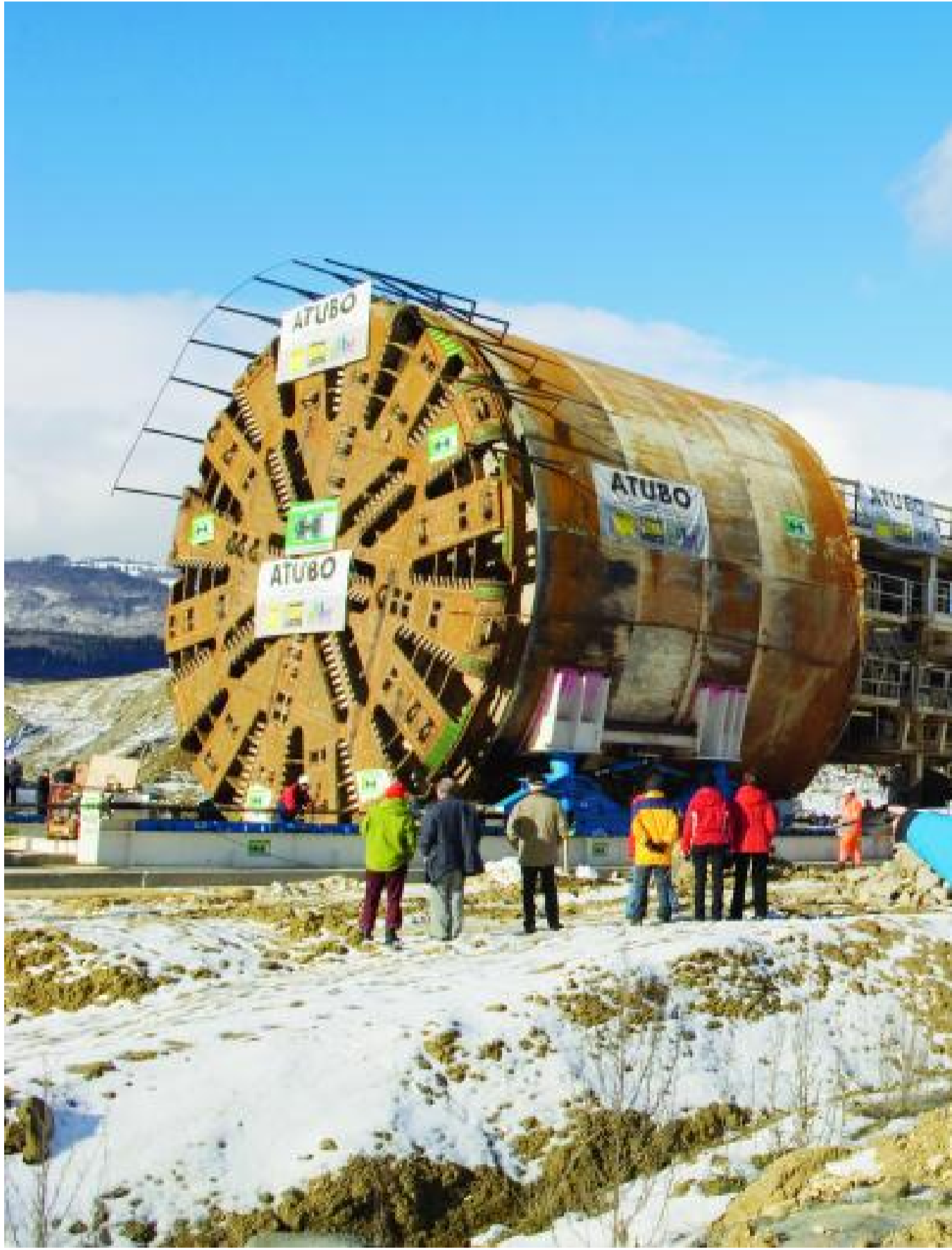
Im Januar 2010 wird die Tunnelbohrmaschine Belena in Orpund auf offenem Gelände verschoben. Dafür muss eine provisorische Brücke
