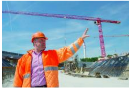
Thomas Varrin, Oberbauleiter für den Abschnitt Brüggmoos, 2015 auf seiner Baustelle. psj
