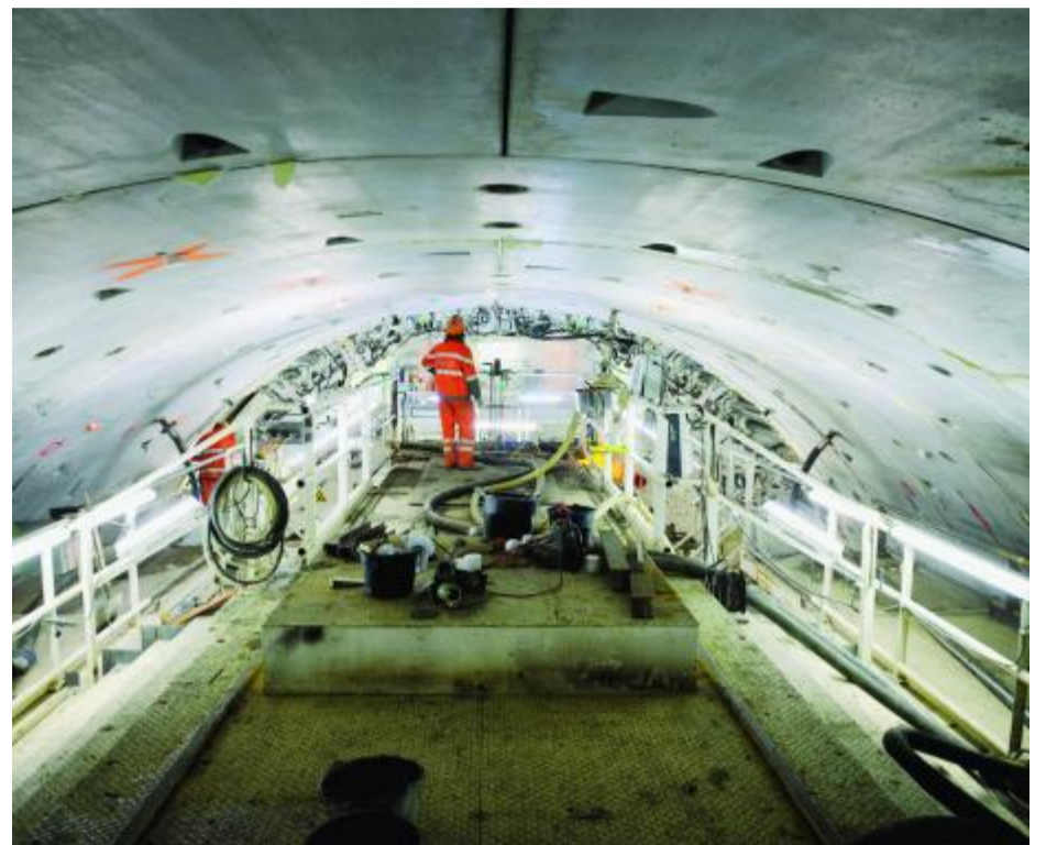
2010 auf der Tunnelbohrmaschine Belena im Längholtunnel. Adrian Streun
