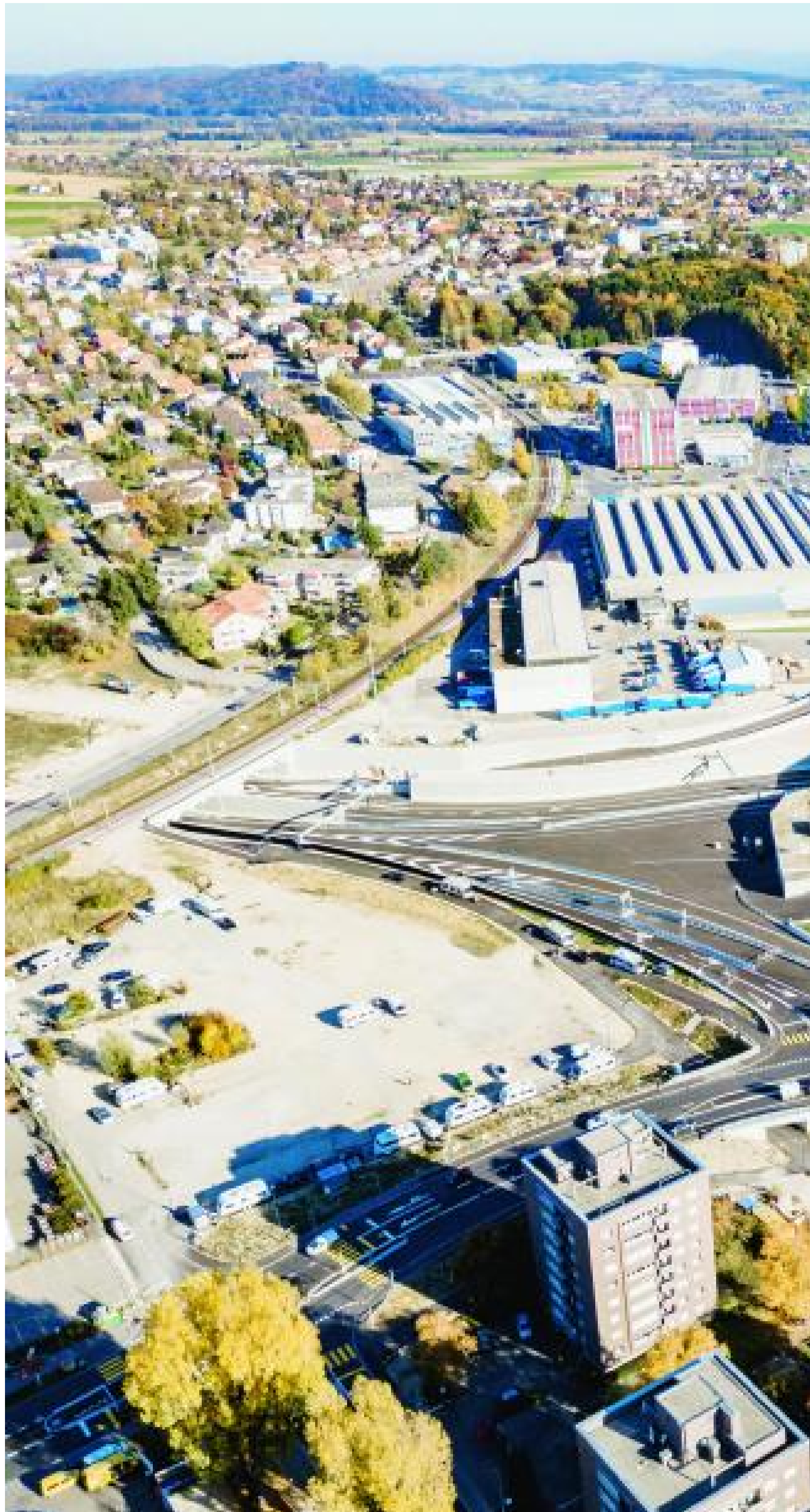
Die Verzweigung Brüggmoos war neben dem Bau der Tunnel die grösste Baustelle im Zusammenhang mit dem Ostast. Bilder: Matthias Käser
