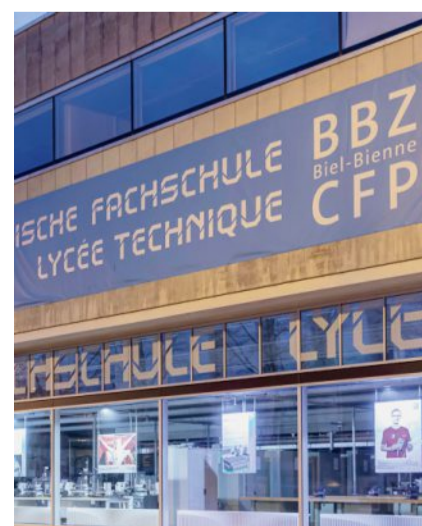
Während der Renovierung des BBZ werden die Lernenden temporär an provisorischen Standorten unterrichtet. RAPHAEL SCHAEFER/FA
